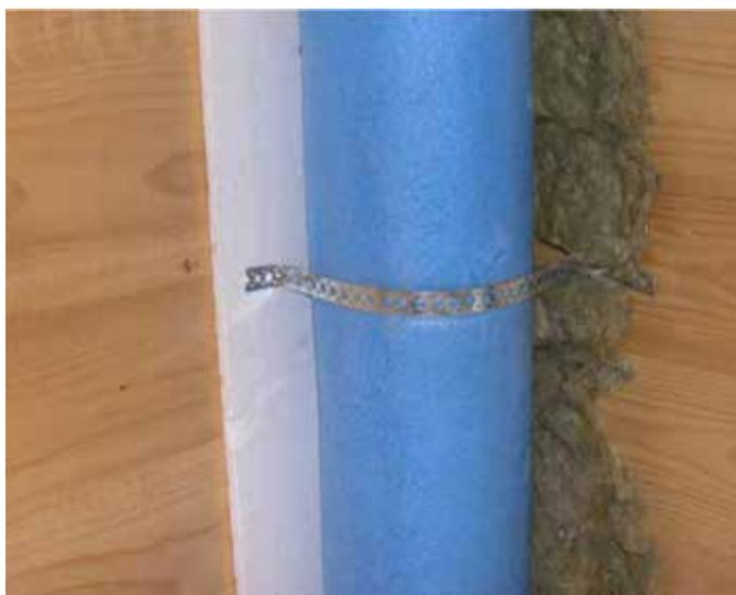
Tubazione di scarico ricoperta con materiale fonoisolante
