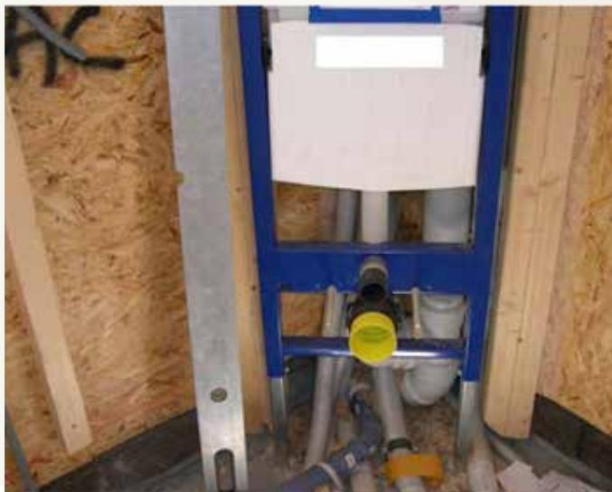
Impianti di adduzione e scarico per WC: evitare possibilmente una eccessiva concentrazione di tubazioni
