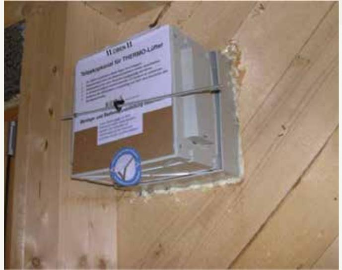
Impianto localizzato di ventilazione con recupero di calore
