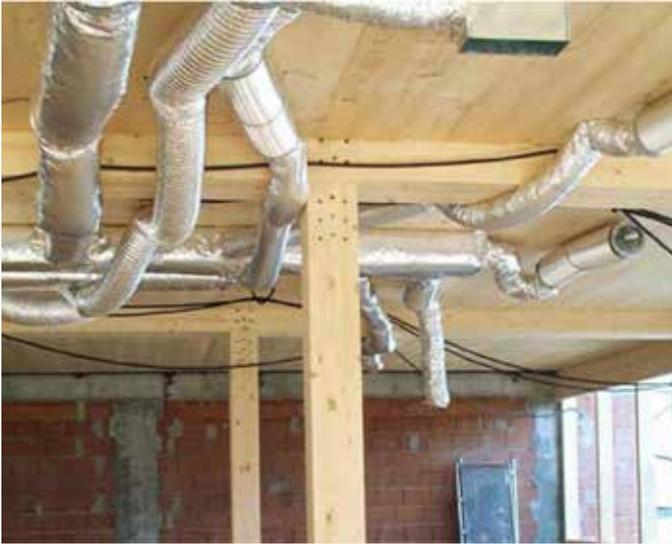
Passaggio a soffitto di tubazioni per impianto centralizzato di ventilazione con recupero di calore
