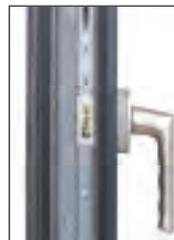
Il profilo anta, con doppia guarnizione di battuta, garantisce un'elevata resistenza al vento oltre ad un ottimo isolamento acustico.
